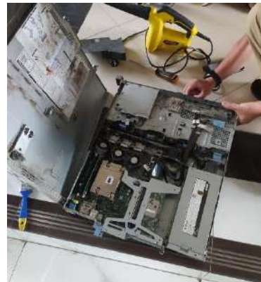
Gambar 3.8. Proses Pembersihan kotak Server.
